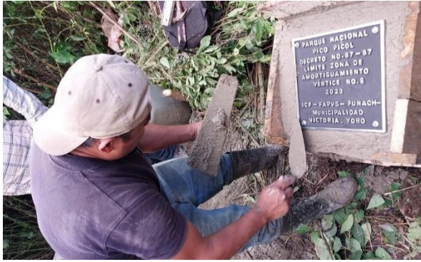
Figura 75. Construcción del hito
