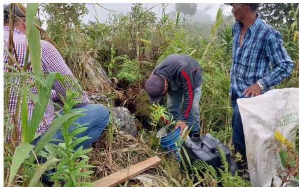
Figura 62. Construcción de base
