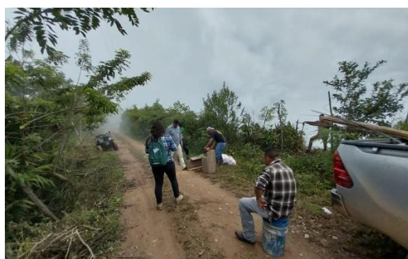
Figura 40. Preparación del sitio
