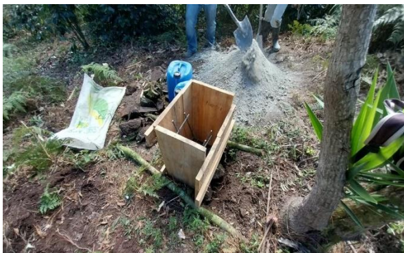
Figura 55. Construcción de hito
