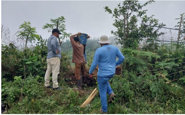
Figura 41. Construcción de hito
