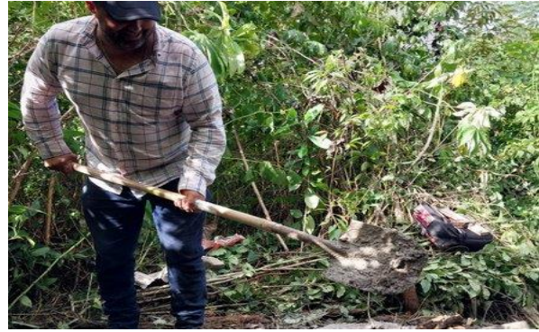
Figura 76. Construcción del hito
