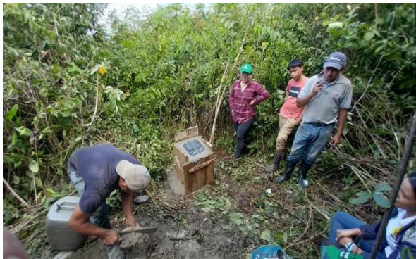
Figura 77. Instalación de placa
