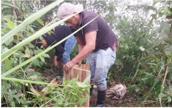
Figura 69. Construcción del hito
