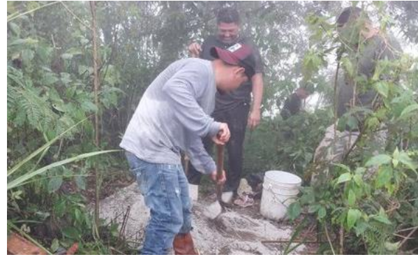
Figura 70. Construcción del hito
