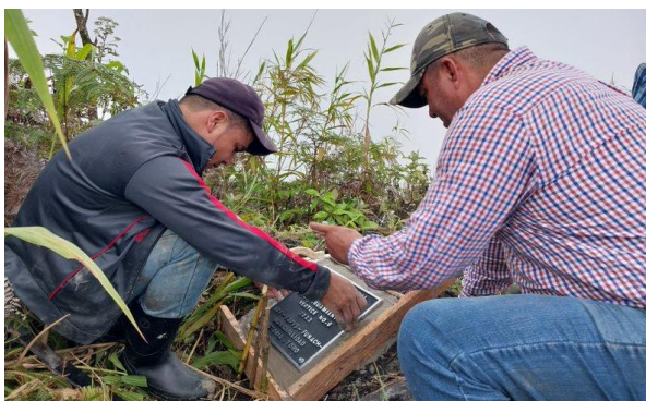
Figura 63. Instalación de placa
