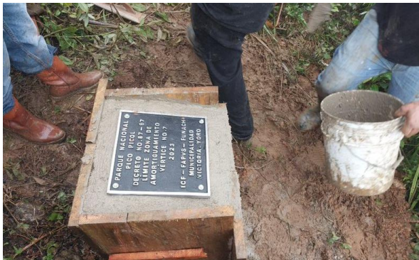
Figura 71. Instalación de placa
