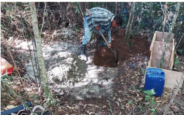
Figura 45. Preparación del sitio
