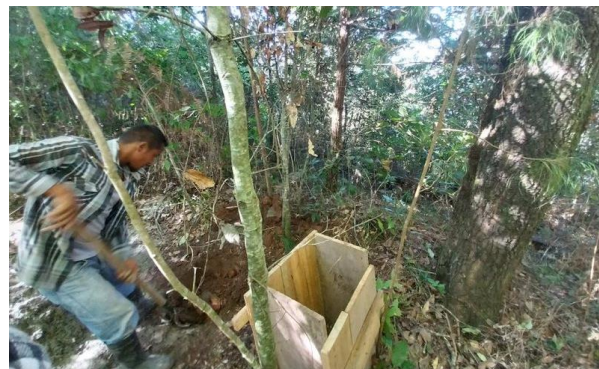
Figura 46. Preparación del sitio
