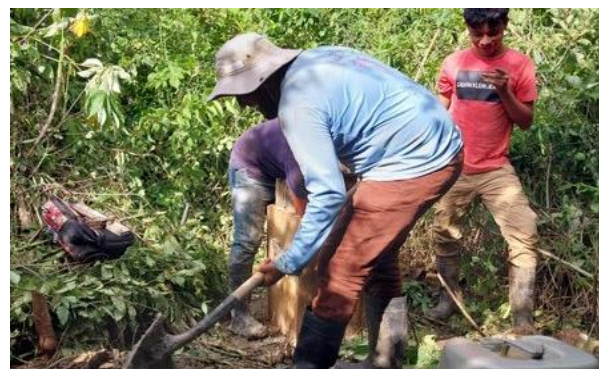
Figura 74. Preparación del sitio
