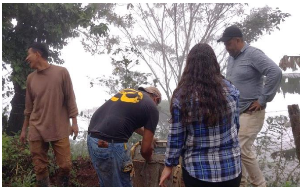
Figura 33. Construcción de hito
