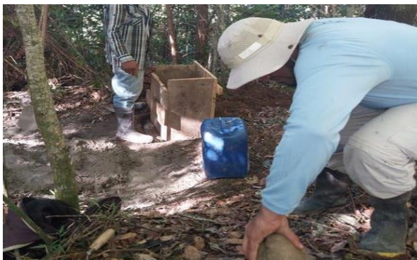
Figura 47. Construcción de hito
